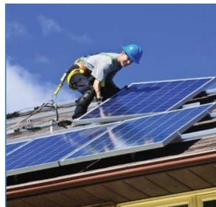
7. Durante las operaciones de instalación de placas solares con riesgo de caída de altura amarrar los cinturones de seguridad a puntos resistentes.
