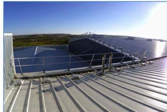
Una vez elegido el método de trabajo en altura, se deberá balizar la zona de trabajo para evitar el riesgo de caída de objetos a terceros, se prepararán los accesos, los puntos de anclaje y los medios necesarios para poder ejecutar los trabajos en condiciones de seguridad.
