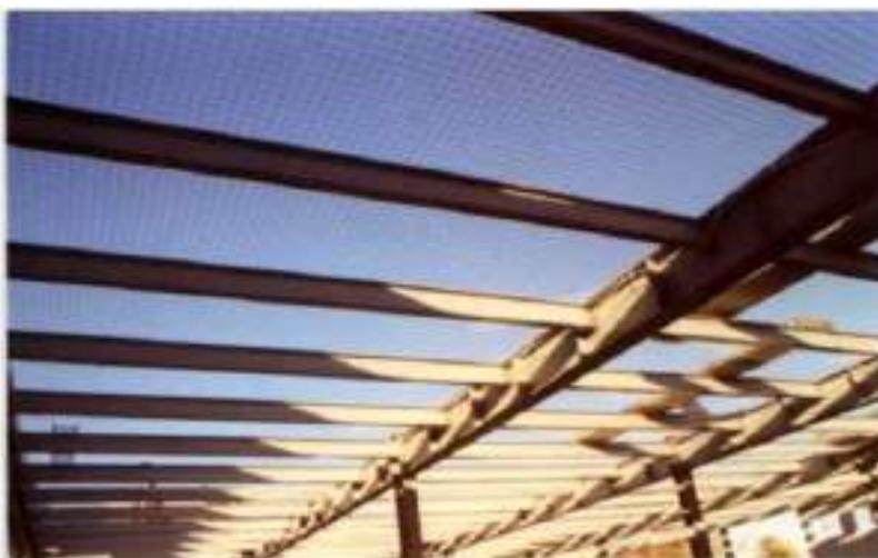
Estos medios forma parte de la denominada protección colectiva, y cuando no se puedan adoptar se deberá utilizar los medios o sistemas de protección individual, como el arnés con dispositivo anticaída anclado o unido a puntos fijos de suficiente resistencia (cables fiadores, líneas de sujeción, anillas o anclajes, etc...)
