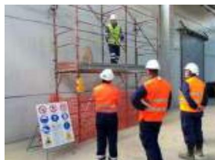
El montaje de un andamio apoyado consiste, básicamente, en la unión de elementos metálicos horizontalmente, verticalmente y en diagonal conformando la estructura requerida con la resistencia, rigidez y estabilidad necesarias.
