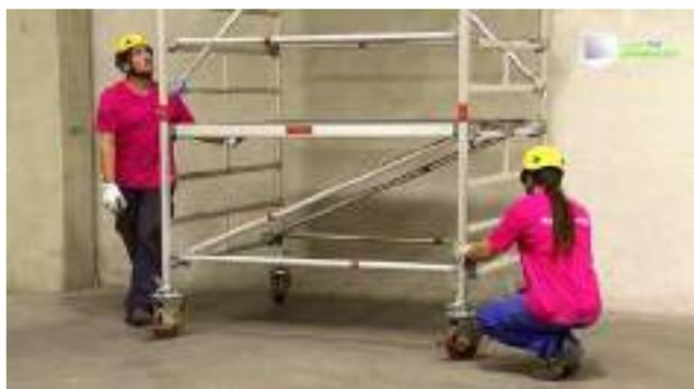
En general, es aconsejable limitar la altura de estas torres (altura de la plataforma de trabajo desde el suelo) a 8 m en espacios exteriores y a 12 m en zonas interiores o al abrigo del viento. En cualquier caso, deberán seguirse las instrucciones del fabricante en cuanto a altura máxima.
