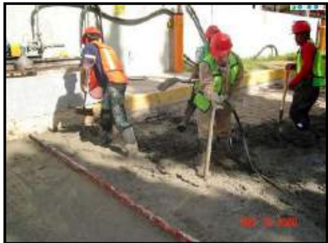
**Curado:** Una vez concluido el vaciado y después del fraguado del hormigón, es preciso mantenerlo con un grado suficiente de humedad durante por lo menos 7 días, a fin de completar la hidratación del cemento y desarrollar la resistencia.
