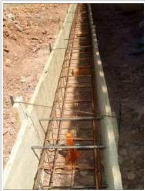
**Zapatas corridas:** Son empleadas generalmente en la construcción de muros. Pueden tener sección rectangular, escalonada o incluso forma cónica. Sus dimensiones están en relación con la carga que han de soportar, la resistencia a la compresión del material y la presión admisible sobre el terreno.
