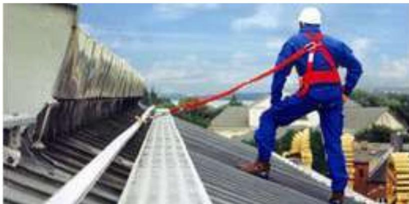
El **arnés anticaídas** puede estar constituido por bandas, ajustadores, hebillas y otros elementos, dispuestos y acomodados de forma adecuada sobre el cuerpo de una persona para sostenerla durante una caída y después de la detención de ésta.
