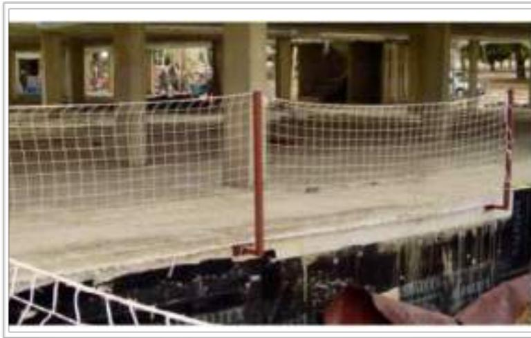
**Redes verticales (para fachadas):** Se pueden utilizar para protección en fachadas, tanto en exteriores como las que dan a grandes patios interiores. Van sujetas a unos soportes verticales o al forjado.
