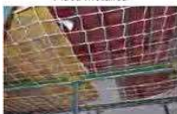
Red reutilizable anclada en placas metálicas
