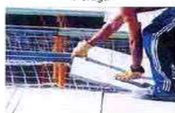
En tablado con la red instalada
