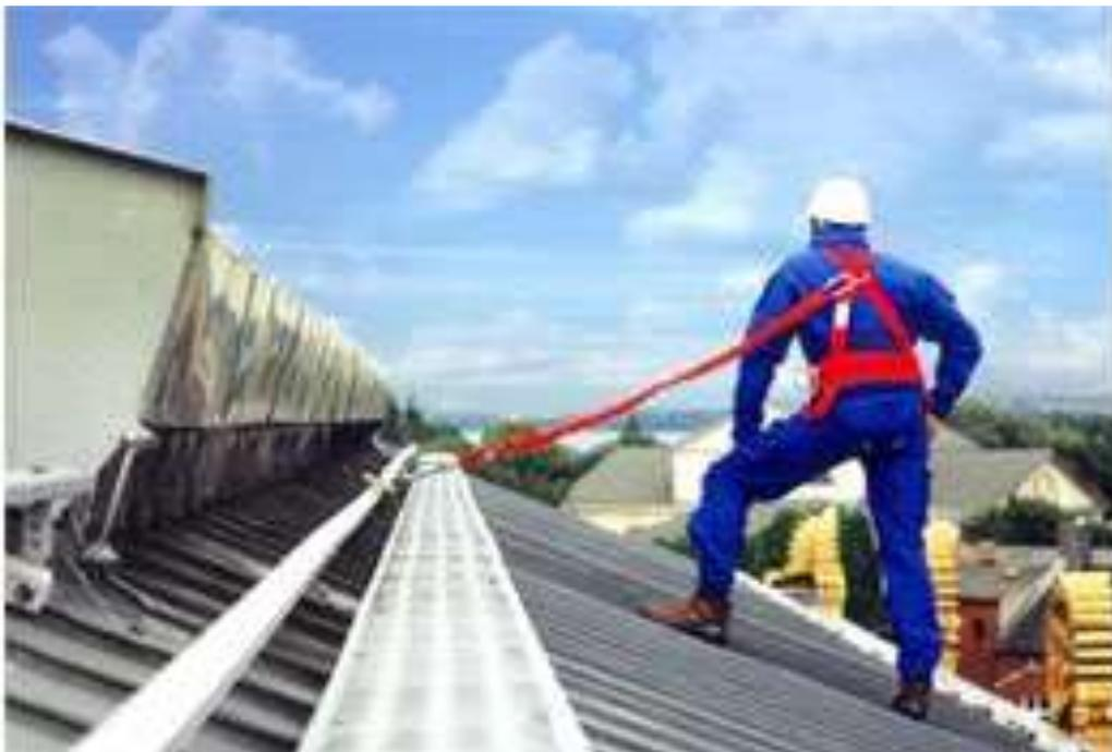
El arnés anticaídas puede estar constituido por bandas, ajustadores, hebillas y otros elementos, dispuestos y acomodados de forma adecuada sobre el cuerpo de una persona para sostenerla durante una caída y después de la detención de ésta.
