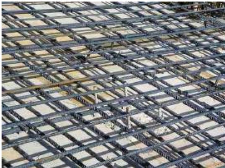
Solamente se elabora la ferralla en obra cuando la magnitud de esta es considerable y la ferralla no podría ser armada previamente. Entonces se realizará en la misma obra el armado y montaje de la armadura.
