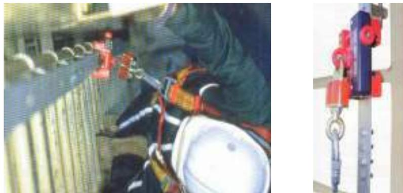
El último tipo de Línea de Vida que nos queda por comentar es la Línea temporal. Esta línea, va cosida a la bolsa, en donde es transportada, y dota al trabajador de un sistema de protección colectiva que puede utilizar prácticamente en cualquier desplazamiento horizontal en altura.
