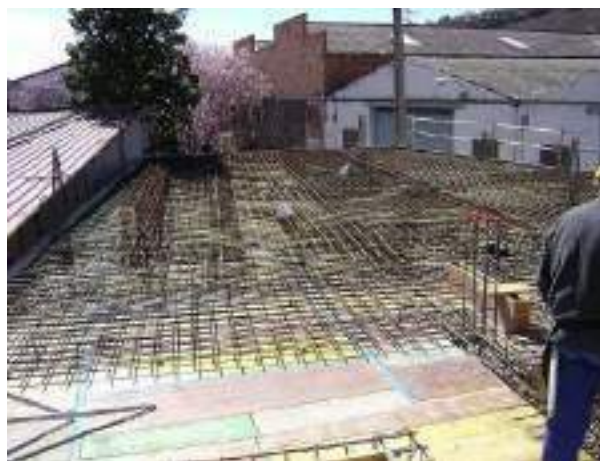
Montaje ferrallado en forjado
