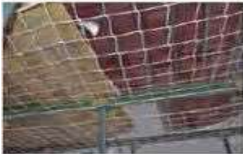
Red reutilizable anclada en placas metálicas
