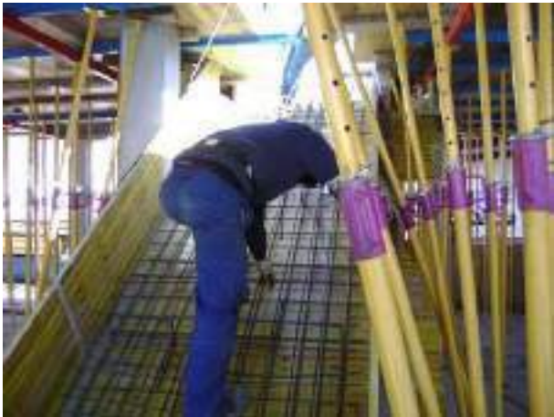
Montaje ferrallado escalera
