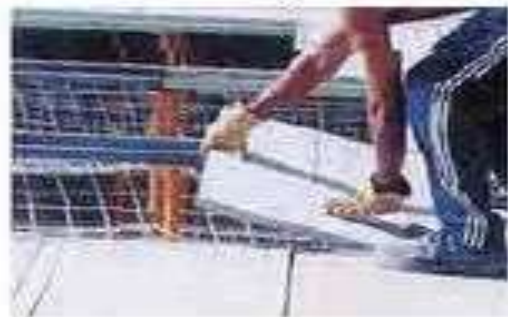
Entablado con la red instalada.
