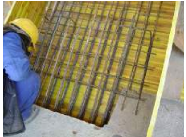
Montaje ferrallado escalera
