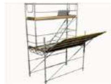
➔ **REDES DE SEGURIDAD:** Son protecciones colectivas que sirven para limitar la altura de caída o para impedirla, son resistentes a los agentes atmosféricos y pueden soportar el peso de un hombre cayendo desde la altura máxima admisible desde dos pisos aproximadamente. Tipos de redes:
