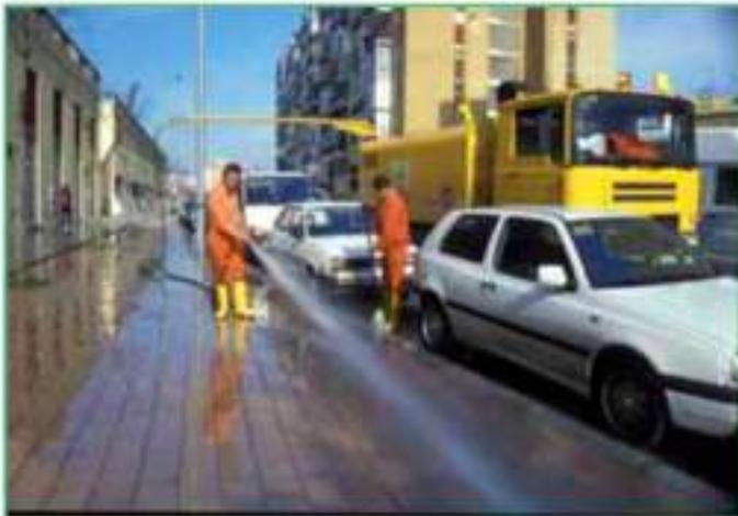
*El Baldeo mixto puede realizarse en turno de noche o de mañana. La dotación de personal añade a la de baldeo manual un conductor. Las baldeadoras van equipadas con un carrete de 35 metros de manguera y una pértiga de baldeo para poder saltar los obstáculos (coches aparcados). Adosado en la parte trasera suelen llevar un aro portabolsas para la recogida de residuos.*
