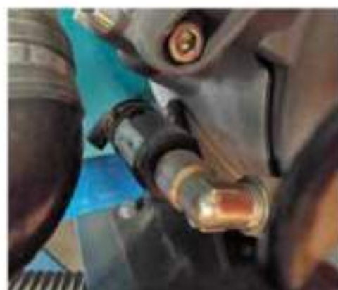
Figura 18. Válvula de seguridad. Se observa que está mal instalada ya que el retorno no lo hace al depósito.
